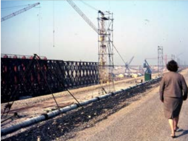
Figuur 4.13 : Bouw caissons in de haven van Bommenede (1968-1969)
