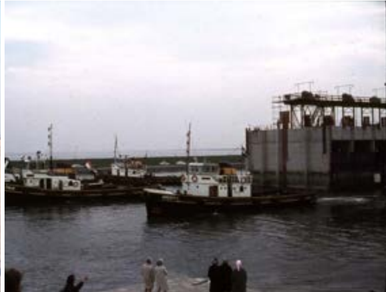
Figuur 4.14: Uitvaren caissons 1971
