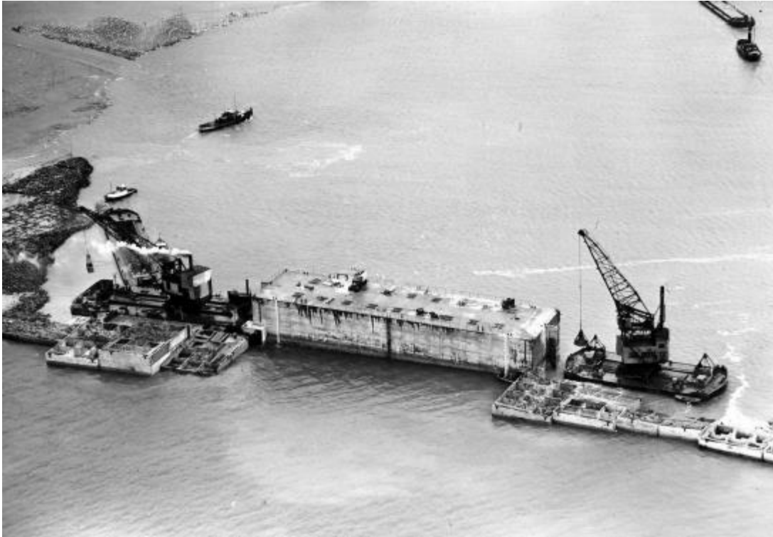
Figuur 4.6: Dichting van het dijkgat bij de Schelphoek
