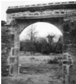
Na de verbouwing.
